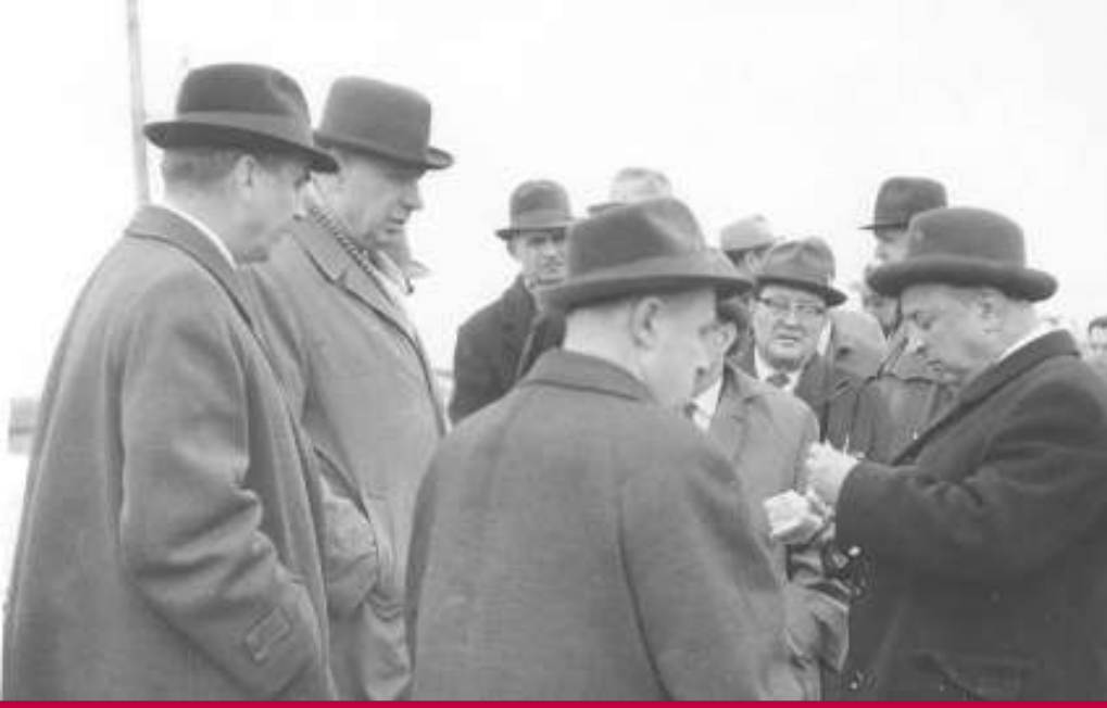
Н.Ф. Семизоров, Н.В. Разин, В.Я.Кан на строительной площадке. 1968 г.
